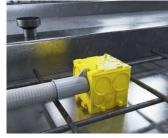
Insert the conduit into the conduit connector.
