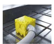
Insert the conduit in engaged conduit connector 60°.
