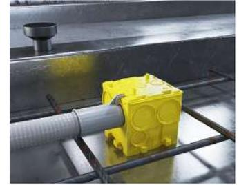
Insert the conduit into the conduit connector.
